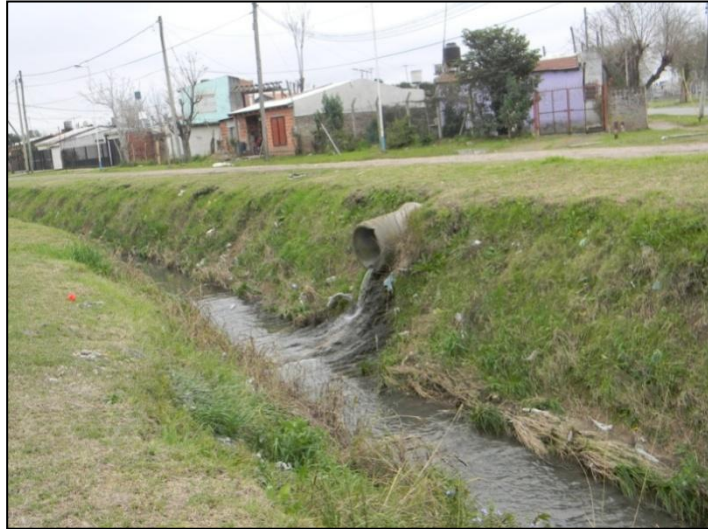
Figura 24: Estación de muestreo E3 ubicada en la intersección del Arroyo Cuzco y la calle Francisco Seguí en la localidad de Grand Bourg. Fecha 29-07-2014.
