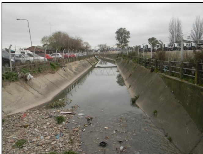
Figura 30: Estación de muestreo E9 ubicada en la intersección del Arroyo Claro y Colectora Escobar en el Área de Promoción Industrial. Fecha: 29-07-2014.
