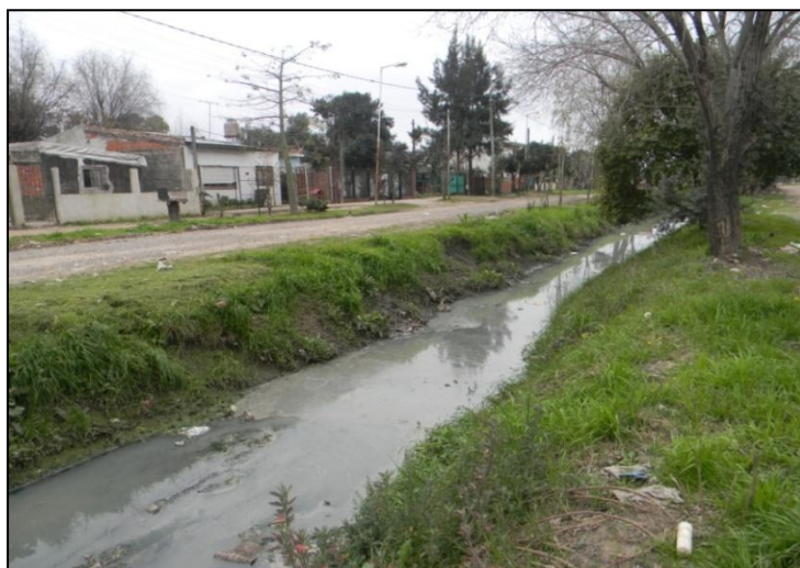
Figura 23: Estación de muestreo E2 ubicada en la intersección del Arroyo Cuzco y la calle Hernández en la localidad de Grand Bourg. Fecha: 29-07-2014.
