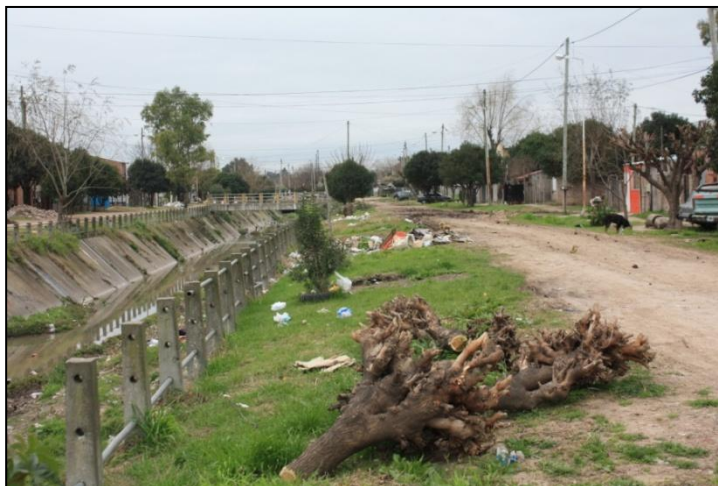
Figura 22: Estación de muestreo E1 ubicada en la intersección del Arroyo Claro y la calle Hernández en la localidad de Grand Bourg. Fecha: 29-07-2014.
